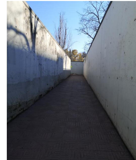
Imatge 9. Paviment de terratzo a la rampa d'accés al pas inferior.
