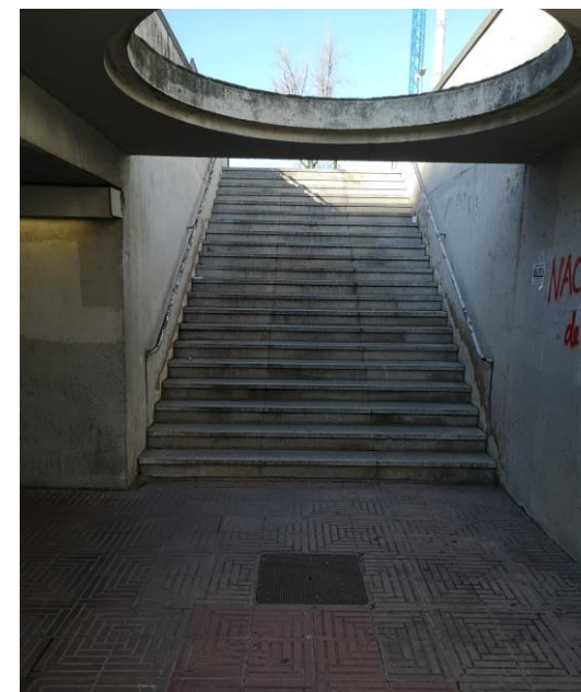
Imatge 8. Escaleres d'accés al pas inferior des de la vorera nord de la Gran Via i llosa estructural amb obertura.
