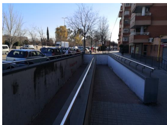
Imatge 6. Rampa d'accés al pas inferior des de la vorera sud de la Gran Via.
