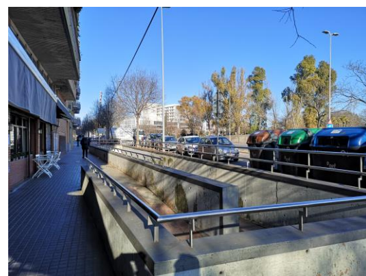
Imatge 7. Murs i passamans de la rampa d'accés al pas inferior.
