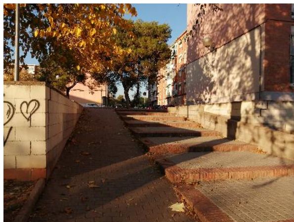
Escala i rampa de connexió amb el polígon
