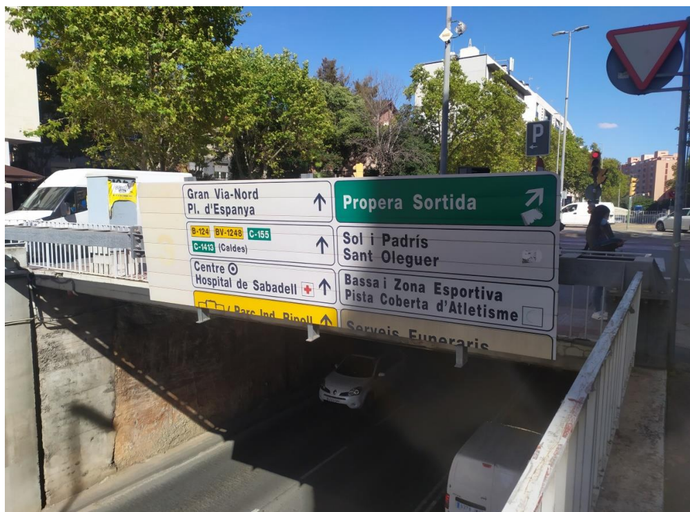
Fotografia 5. Vista lateral pont i murs de contenció Gran Via
