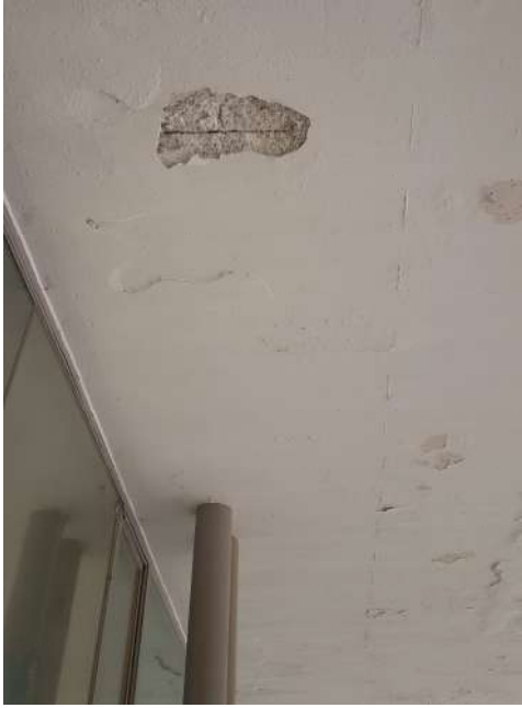
(5) A bombament, trencament i desprendiments de parts del formigó de recobriment del forjat
