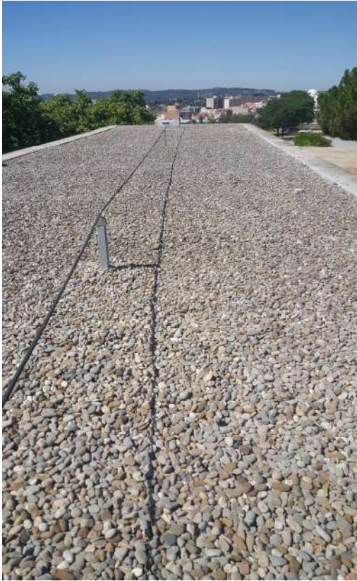
Vista coberta plana invertida
