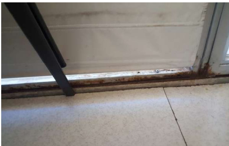
(8) Escopidor de les finestres que donen al carrer Prat de la Riba, de pedra natural sense goteró
