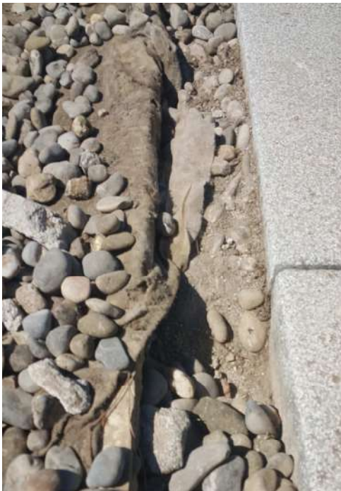
(1) Geotextil, plaques d'aïllament i parts del formigó de pendents trencats.
