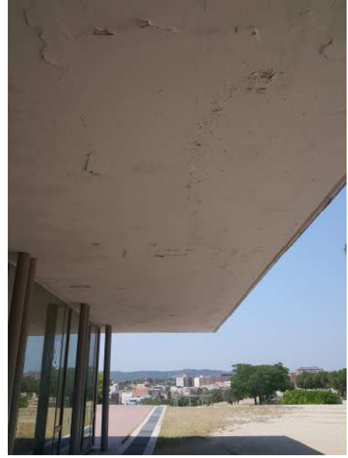
(5) A bombament, trencament i desprendiments de parts del formigó de recobriment del forjat
