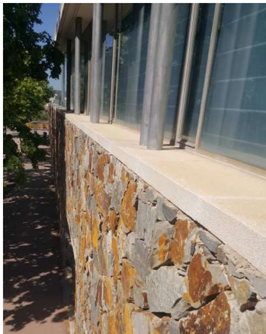
(8) Escopidor de les finestres que donen al carrer Prat de la Riba, de pedra natural sense goteró
