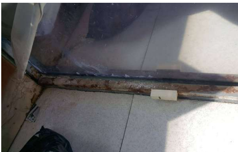
(9) Oxidació de la fusteria de ferro
