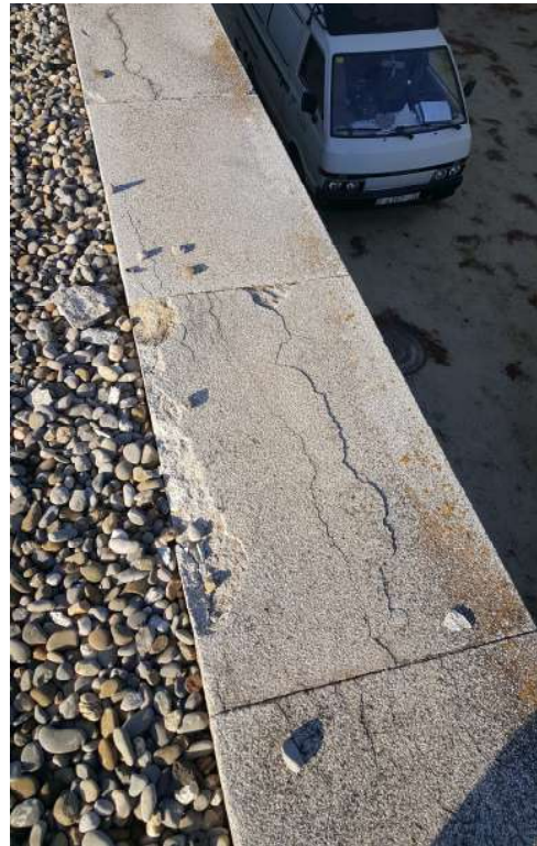
(4) Trencament superficial peces de coronament de pedra natural
