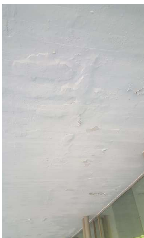
Bombament recobriment forjat de formigó
