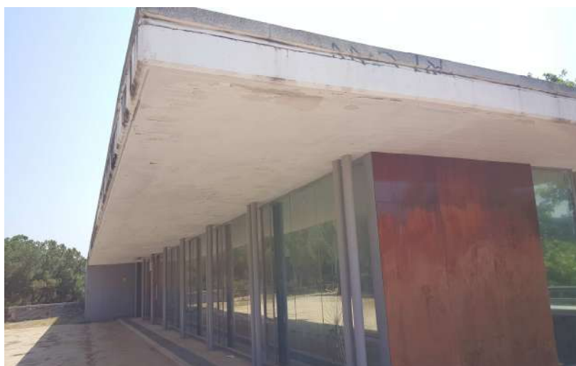
Trobada façanes Nord-Oest / Sud-Oest
