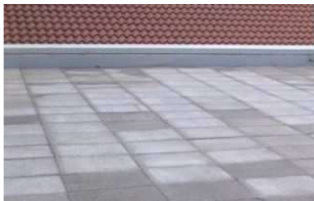
Rajola aïllant poliestirè extruït i paviment de morter de ciment porós
