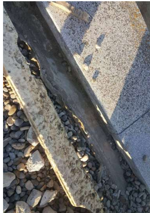
(1) Geotextil, plaques d'aïllament i parts del formigó de pendents trencats.
