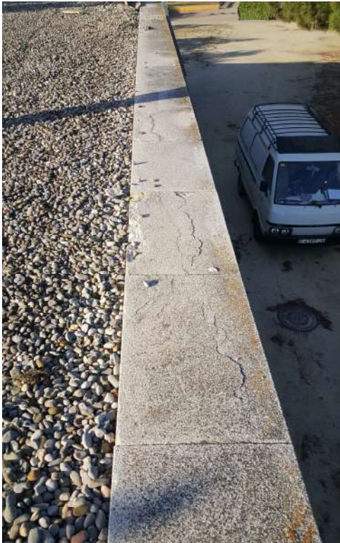
(4) Trencament superficial peces de coronament de pedra natural
