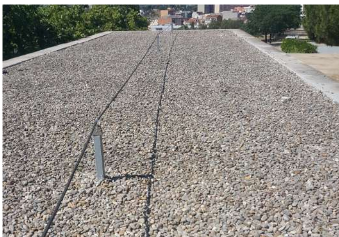
Coberta existent acabat amb graves
