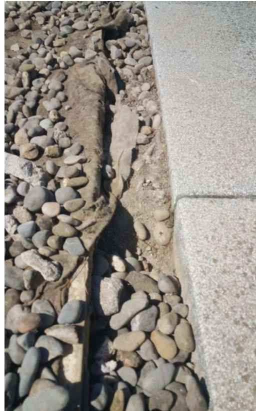
Detall de l'estat general de coberta
