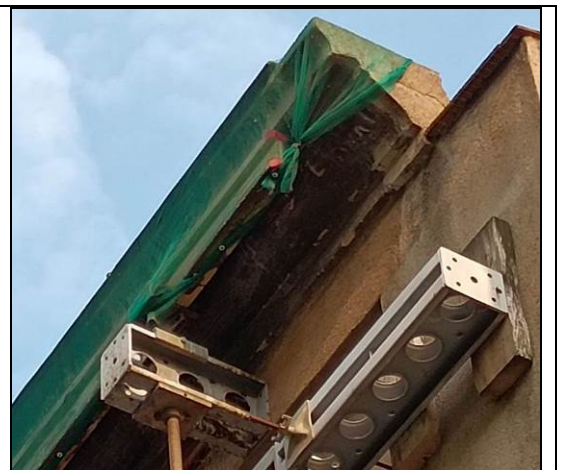
Fotografia dels estabilitzadors existents sota la cornisa perimetral de les façanes de Ca l'Escardat.
