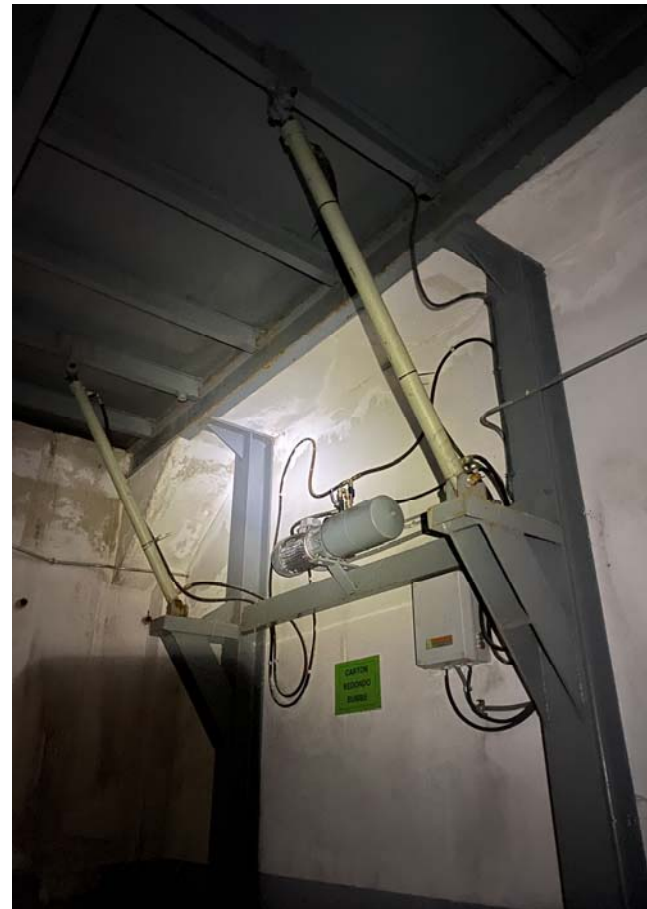
Detall plataforma elevadora existent
