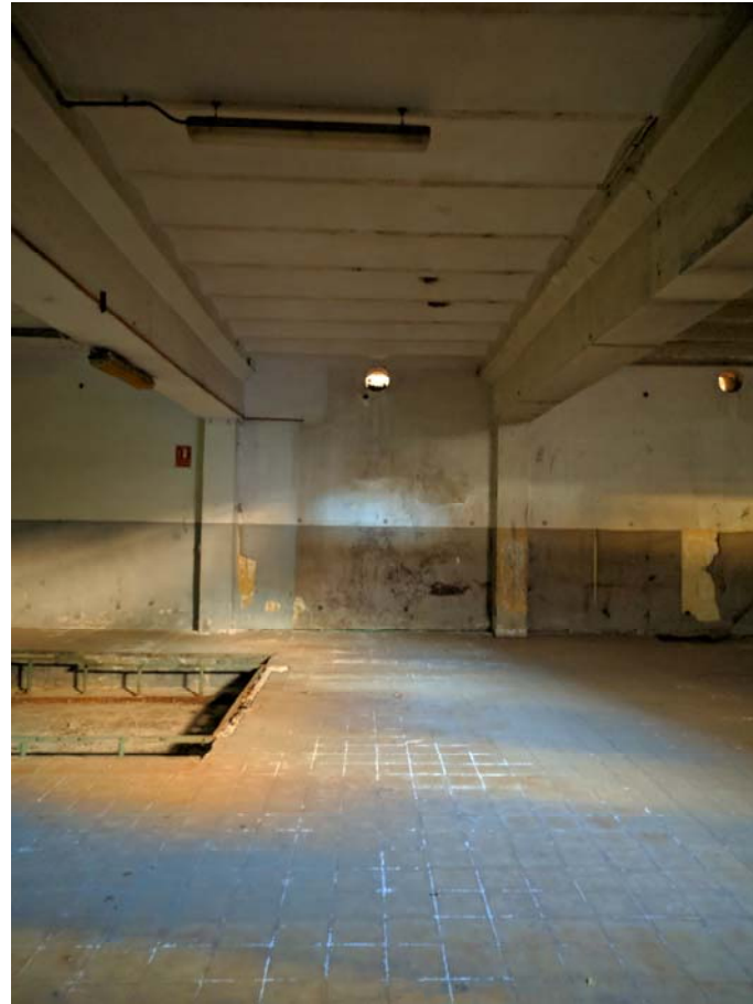
Façana soterrani nau E – sortides ventilacions pati F
