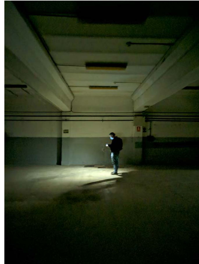
Crugia d'estructura del soterrani nau E
