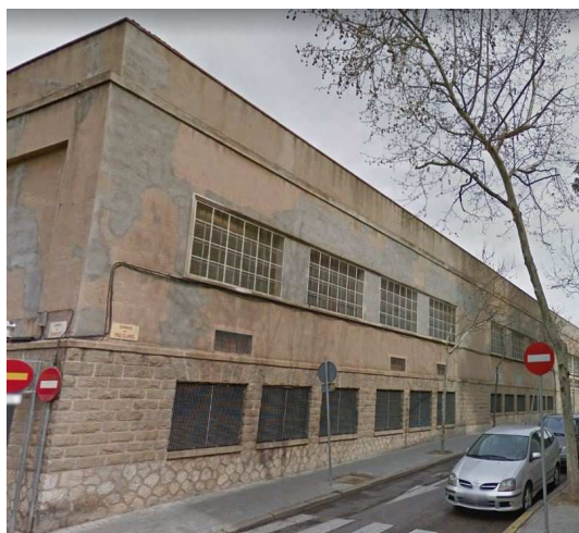
Imatge de la façana de l'edifici de Can Marcet del c. Pau Claris
