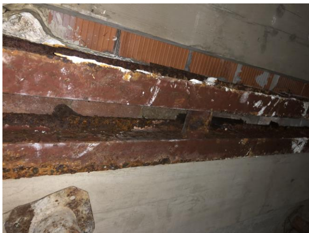
Imatges 012 i 013. Estat de les bigues de ferro d'ala estreta del forjat de la galeria en planta baixa, amb diversos graus d'oxidació.. Font: Elaboració pròpia.
