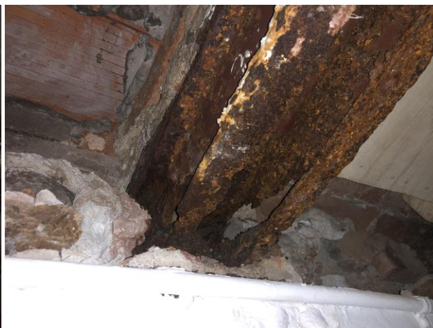
Imatges 012 i 013. Estat de les bigues de ferro d'ala estreta del forjat de la galeria en planta baixa, amb diversos graus d'oxidació.. Font: Elaboració pròpia.
