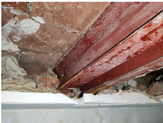
Imatges 010 i 011. Estat de les bigues de ferro d'ala estreta del forjat de la galeria en planta baixa, amb diversos graus d'oxidació. Font: Elaboració pròpia.
