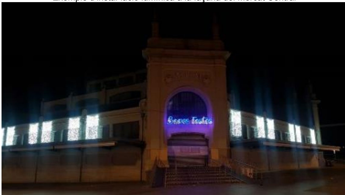
Exemple d'instal·lació lumínica a la façana del Mercat Central
