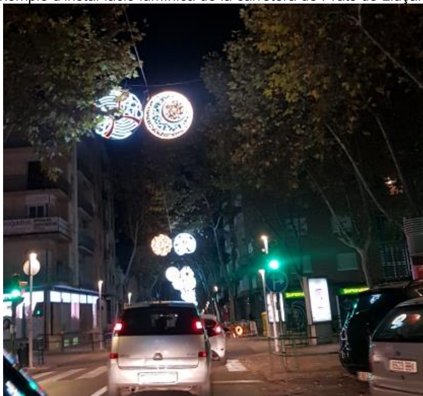
Exemple d'instal·lació lumínica de la carretera de Prats de Lluçanès
