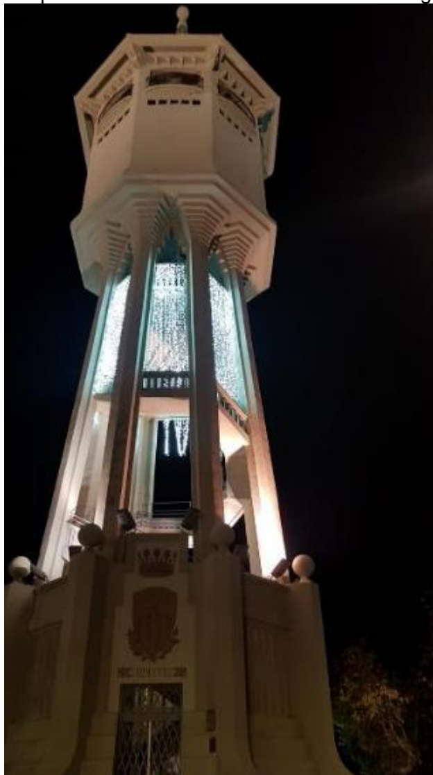
Exemple d'instal·lació lumínica a la Torre de l'Aigua
