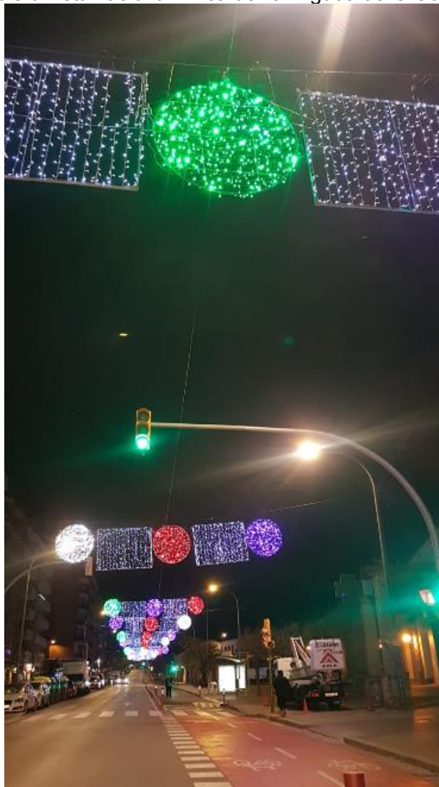
Exemple d'instal·lació lumínica de l'avinguda de la Concòrdia
