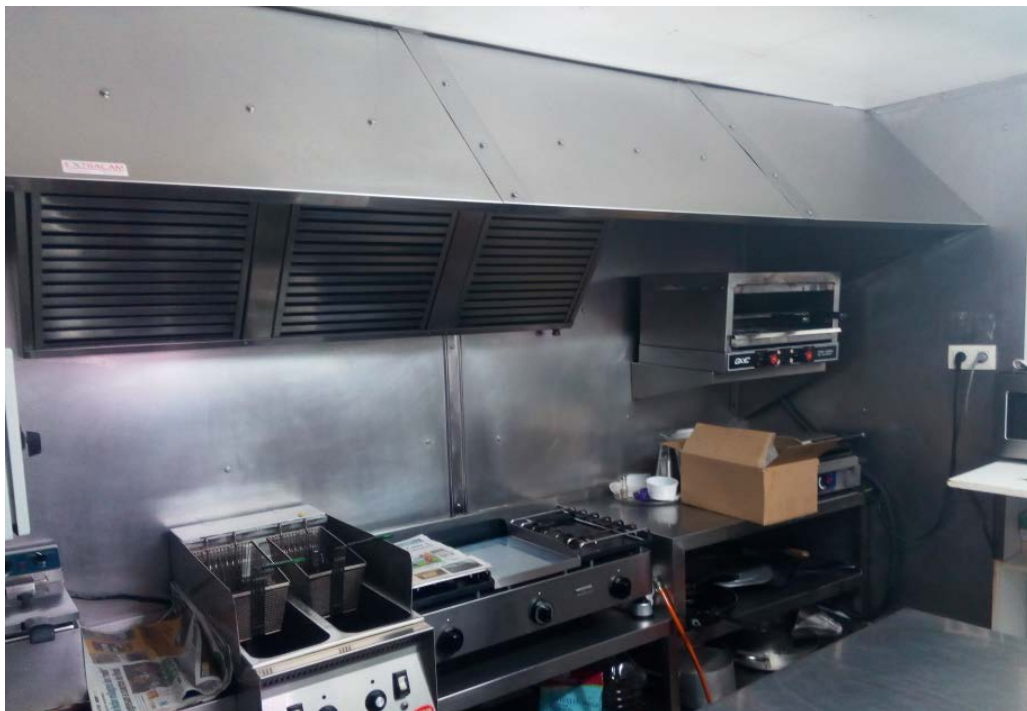
Campana existent de la cuina
