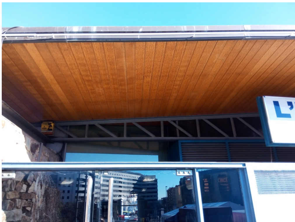
Façana lateral a remodelar
