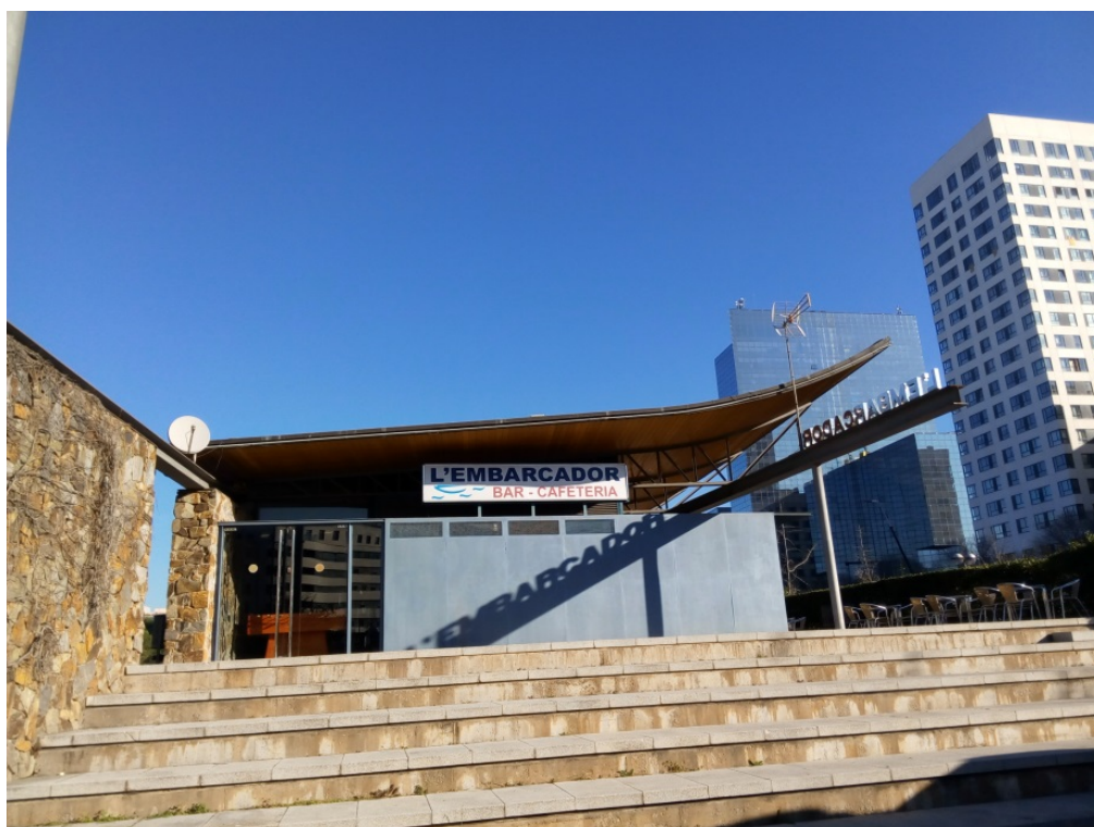
Façana lateral a remodelar
