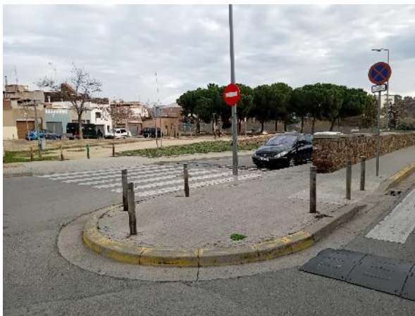
Passos de vianants existents
