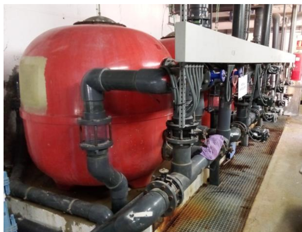
Estat actual dels filtres
