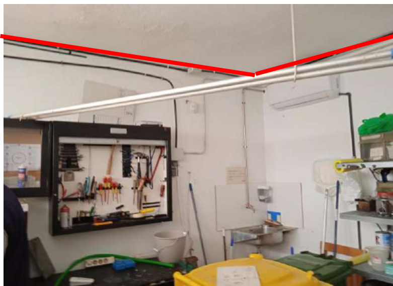
Traçat aproximat alimentació elèctrica a nou Rack i ubicació al magatzem del nou rack
