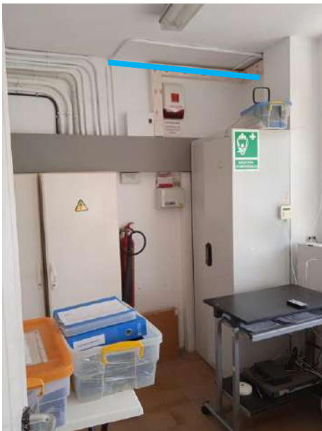
Traçat aproximat alimentació elèctrica i traçat aproximat de conductor de dades per les càmeres
