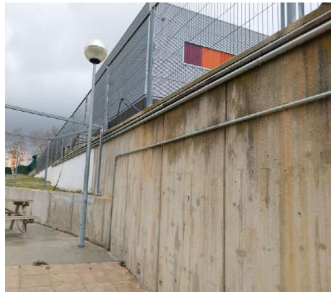
Estesa de tub per paret fins a canvi a estesa soterrada
