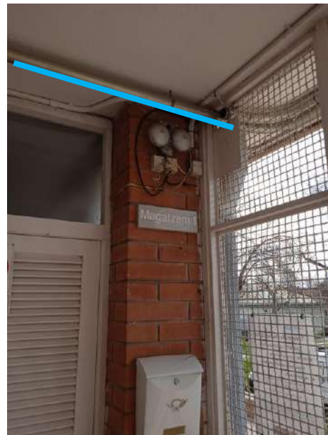
Traçat aproximat alimentació elèctrica i traçat aproximat de conductor de dades per les càmeres
