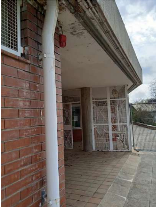
Estesa de tub per sostre aprofitant tub existent
