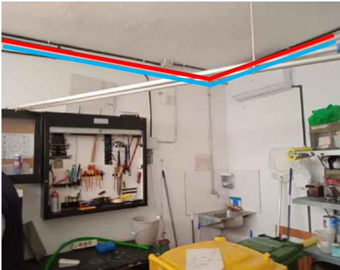
Traçat aproximat alimentació elèctrica i traçat aproximat de conductor de dades per les càmeres
