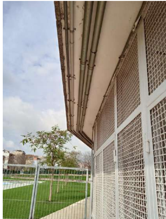
Estesa de tub per sobre aprofitant tub existent
