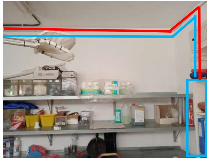
Traçat aproximat alimentació elèctrica i traçat aproximat de conductor de dades per les càmeres
