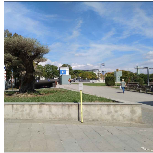
REMAT DEL MUR DEL PARTERRE 1
