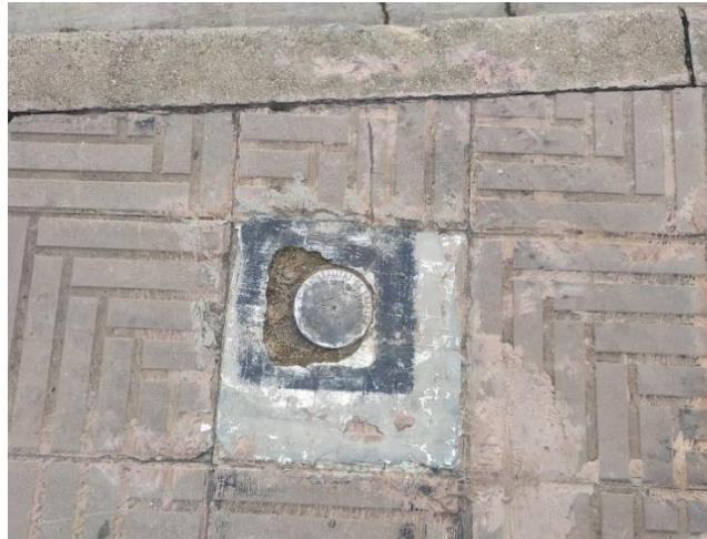
Figura 4. Tapa grafiada amb la simbologia corresponent a una senyal geodèsic pertanyent a la Generalitat de Catalunya, ubicada sobre una de les illetes centrals de la cruïlla (costat est).
