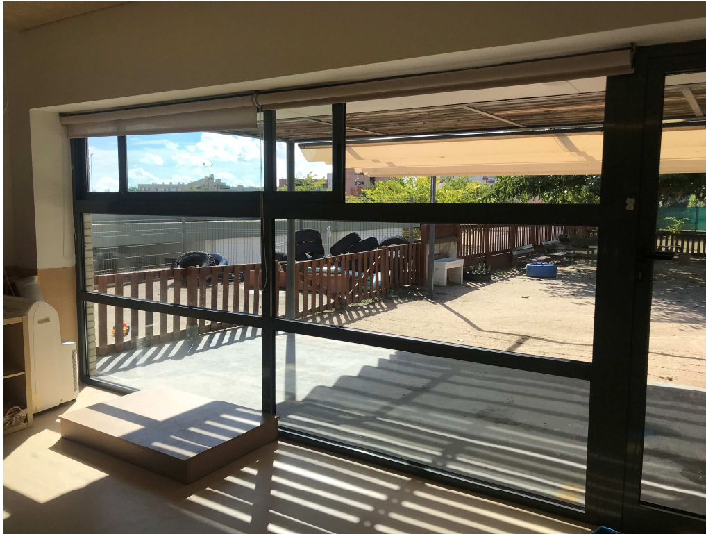
Vista de detall de l'obertura de l'aula 2-3 anys Observeu l'incidència del sol procedent de l'orientació sud-est
