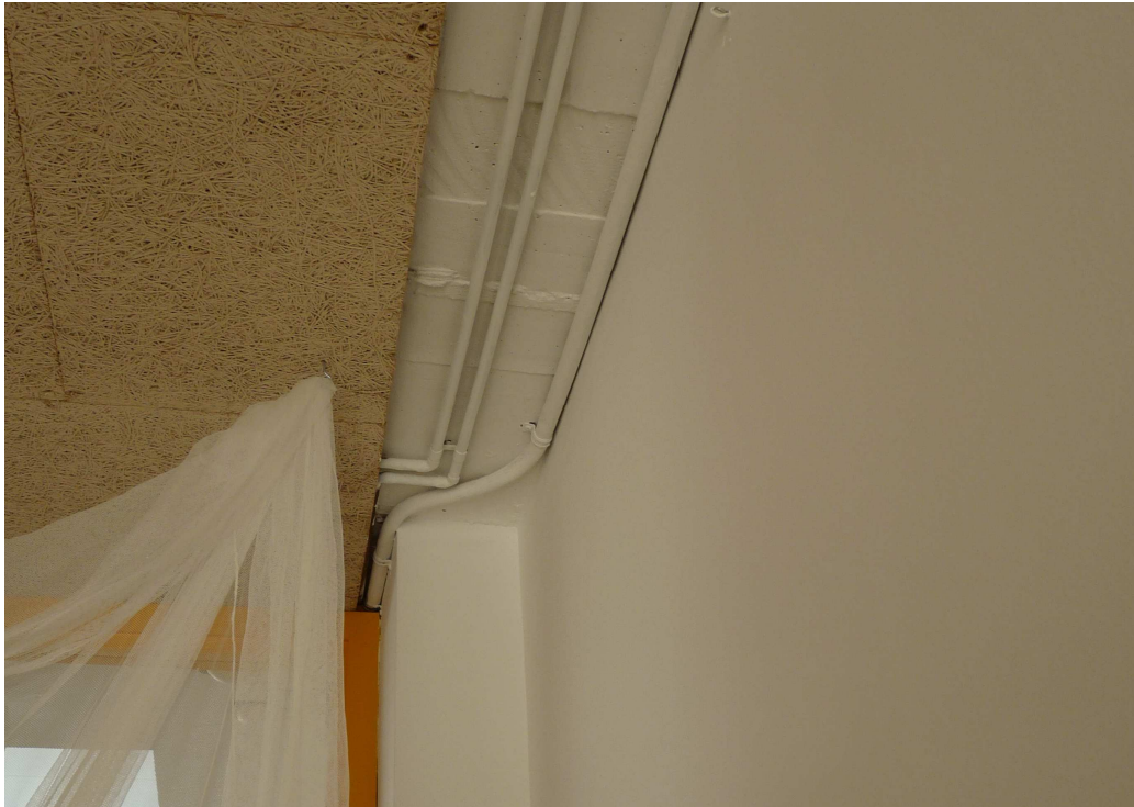
Vista de detall del sostre on atracarà el trasdossat.
