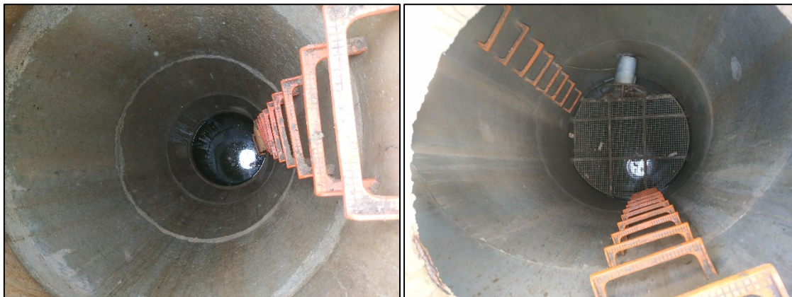
Figura 5: A l'esquerra pou de registre del by-pass; a la dreta pou de registre de la galeria
