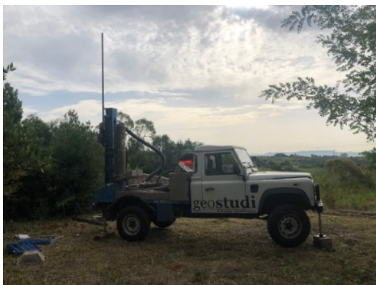
Fot. 7. Treballs de realització del sondeig amb sonda rotativa TP30-LR en el punt 1466S1
