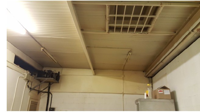
Vista estructura suport coberta secundària
