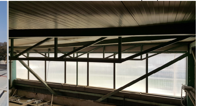
Vista estructura suport coberta principal - corretges
