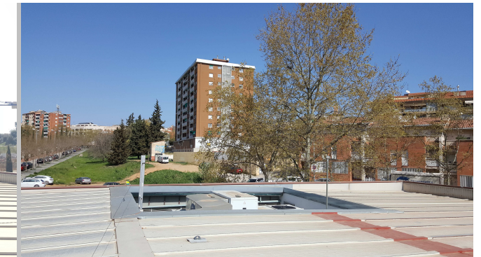
Vista zona accés i instal·lacions coberta principal
