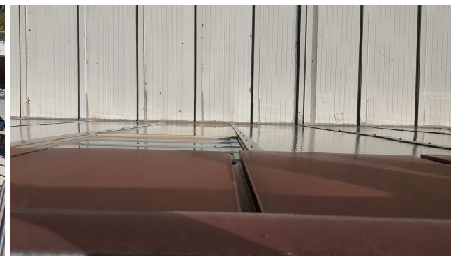
Vista zenital trobada coberta amb façana policarbonats
