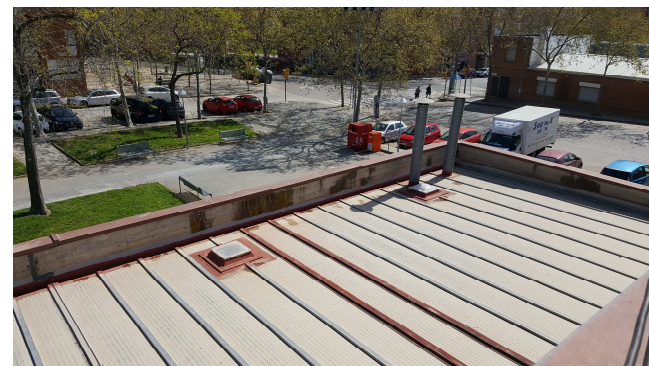
Vista general coberta secundària
