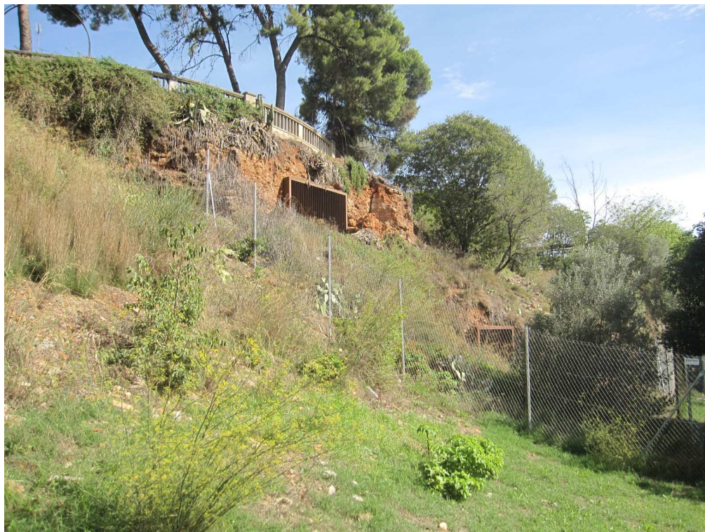
Coves A i B. Vista del conjunt
