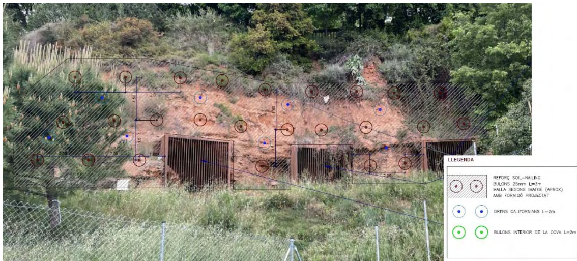
Figura 5.1. Solució 1: Soil-Nailing, zona perfil 1.
