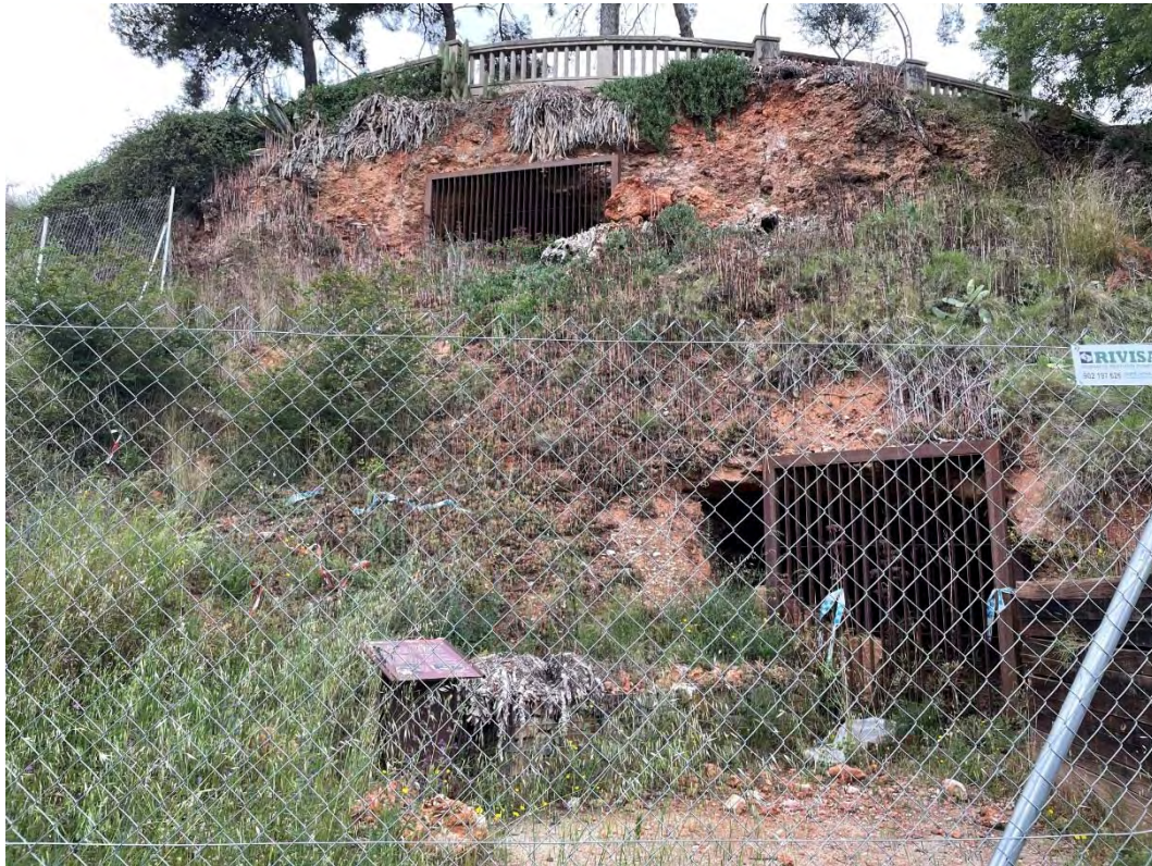
Figura 3.3. Coves Sant Oleguer. Zona perfil 2.
