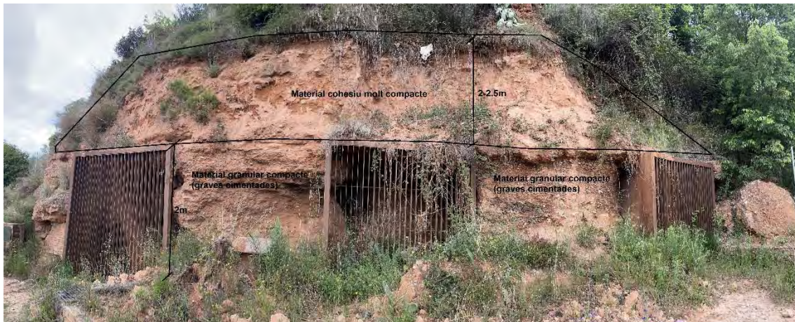
Figura 3.3. Geotècnia zona perfil 1.
