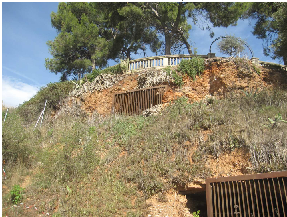
Coves A i B. Vista del conjunt
