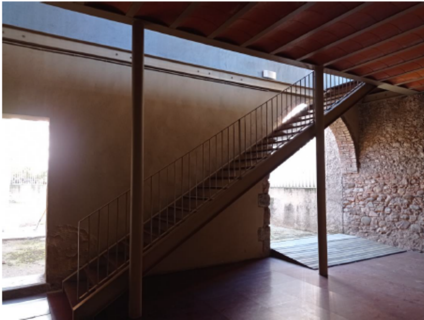
ESPai INTERIOR A ADEQUAR PLANTA BAIXA SABONERIA COSTAT FAÇANA PATI DE LLEVANT
