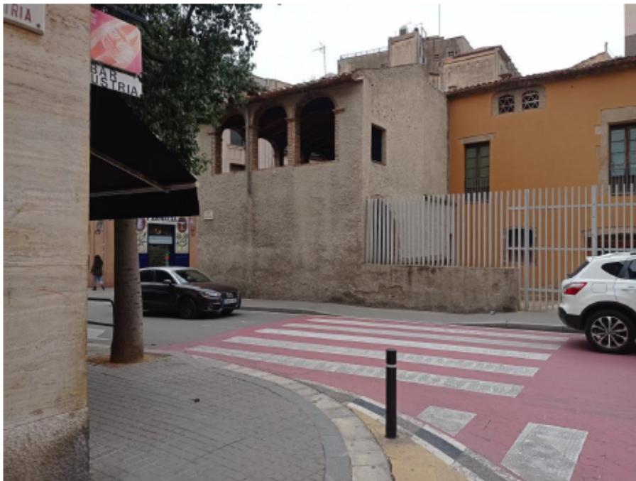
EDIFICI SABONERIA I REIXA ACCÉS PATI DE LLEVANT DES DEL CARRER SANT JOAN
