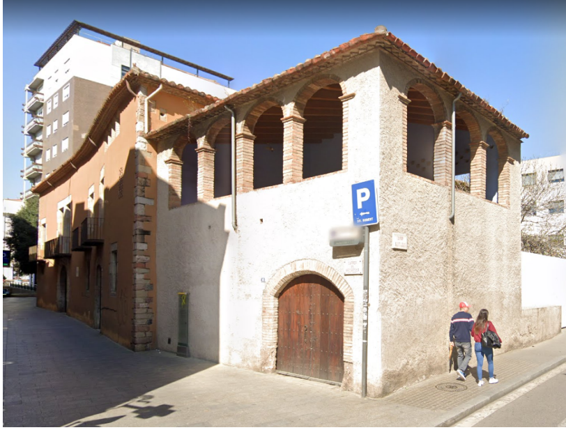
COS AFEGIT DE LA SABONERIA DES DEL CARRER DEL PEDREGAR
