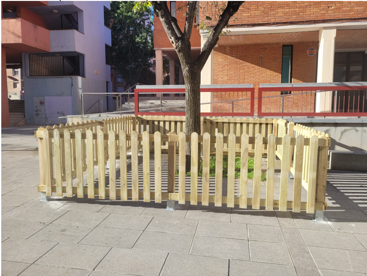
Exemple d'instal·lació de tanques de fusta a l'arbre natural al carrer del Romaní
