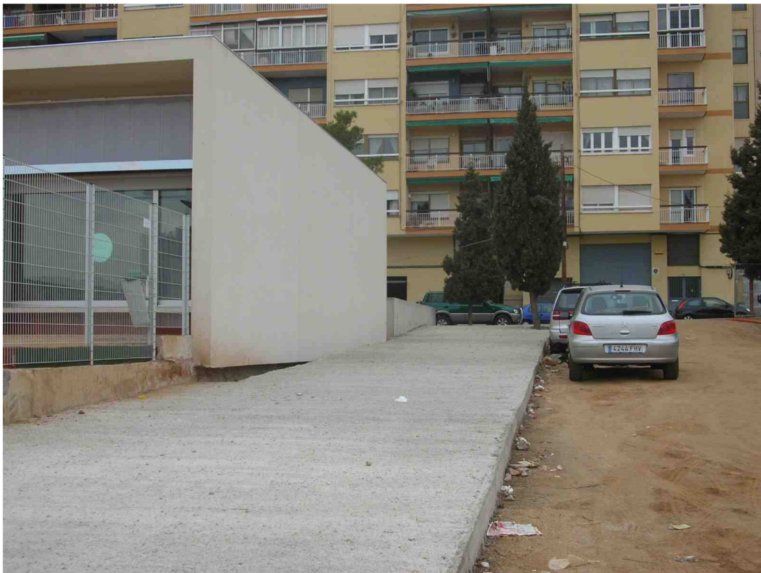
Façana tester est a extradossar
