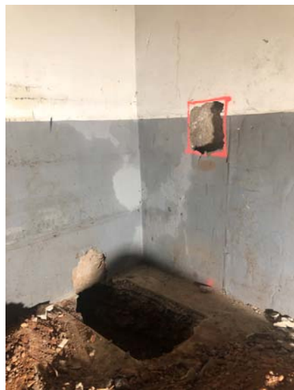
Imatges Cala B1 – Fonament en peu de mur en Soterrani Nau C i trasdossat
