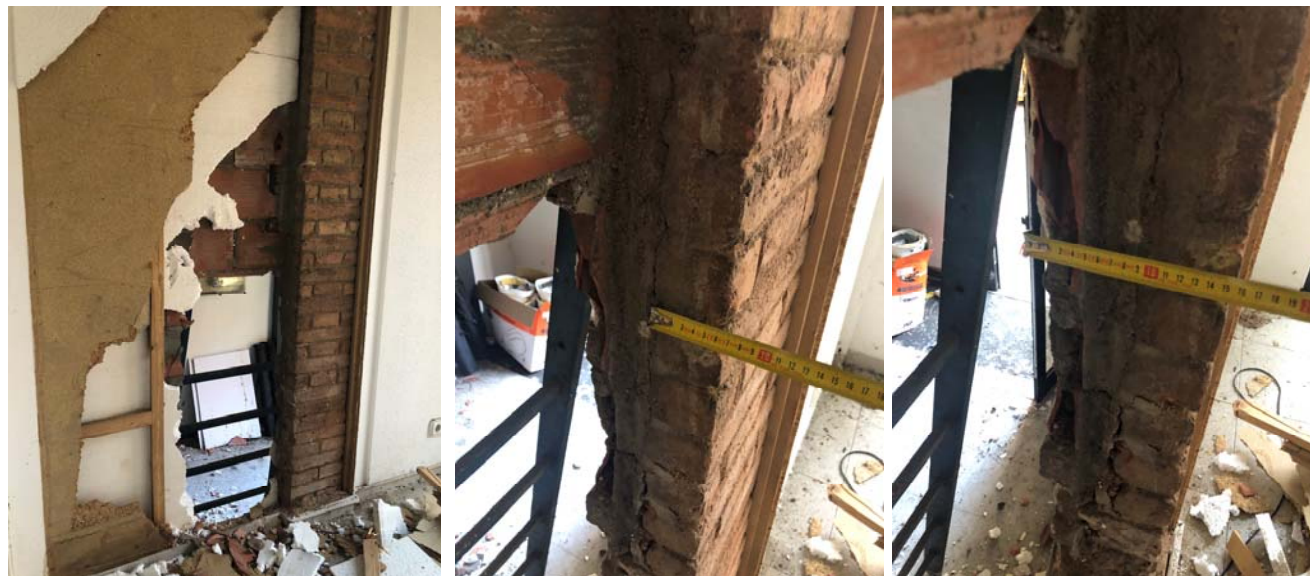
Imatges Cala A9 – Obertura en façana Est Nau H.2
