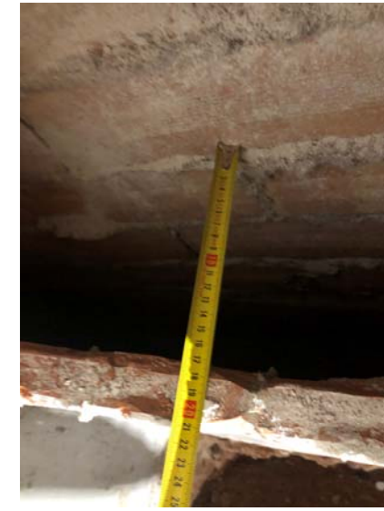
Imatges Cala B5 – Fonament en peu de mur en Soterrani Nau E i trasdossat
