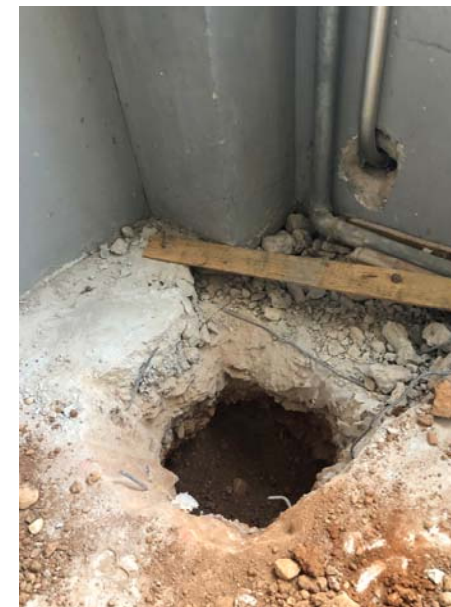
Imatges Cala 5 – Solera armada Nau G
