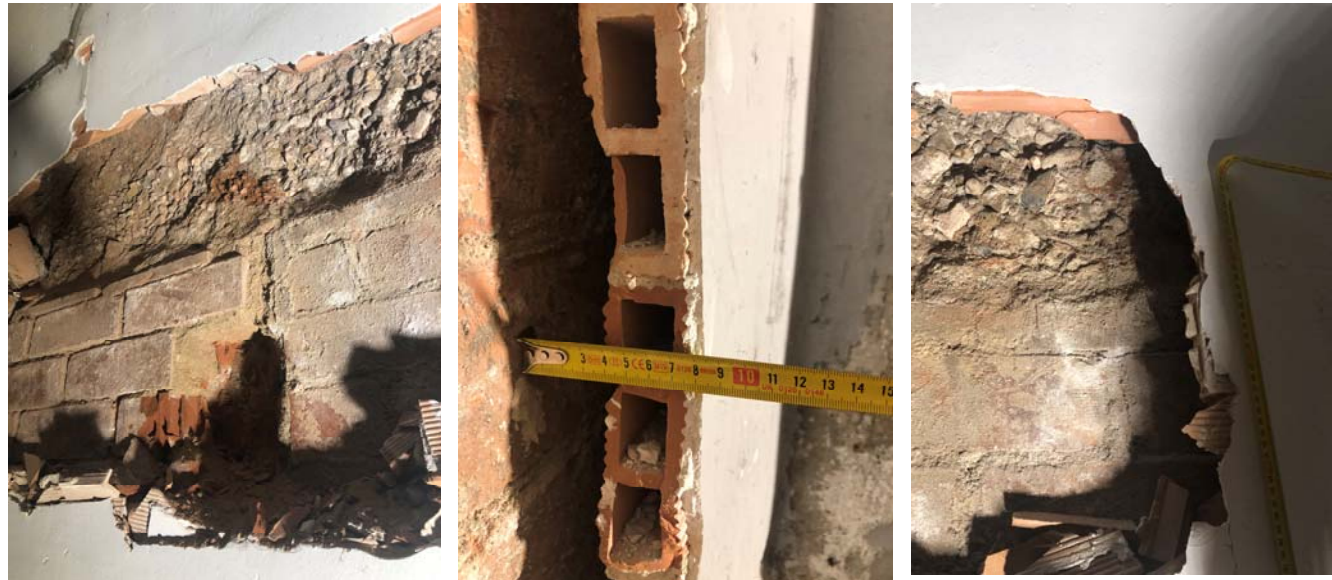
Imatges Cala B6 – Fonament en peu de pilar Nau D
