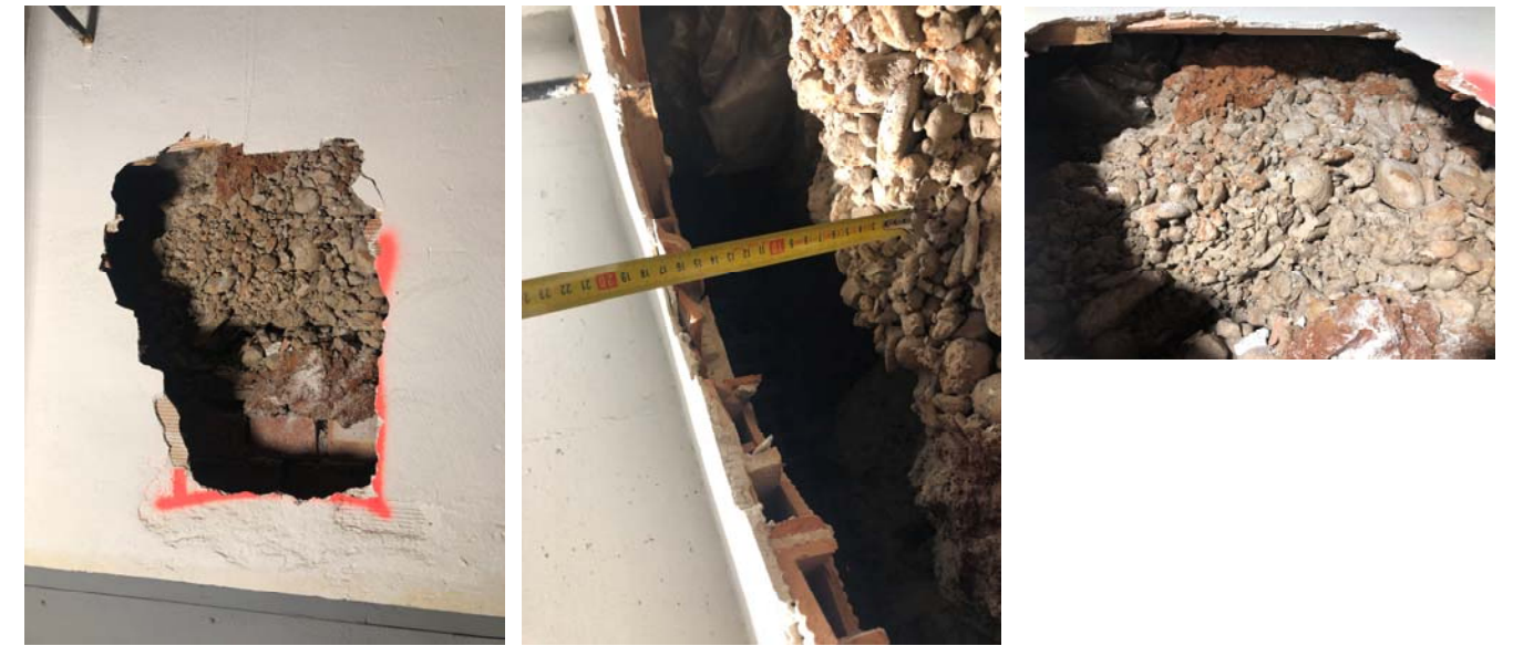
Imatges Cala B4b – Mur entre D i E – cara Nau E
