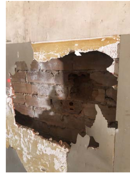
Imatges Cala B5 – Fonament en peu de mur en Soterrani Nau E i trasdossat
