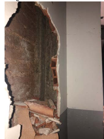
Imatges Cala B2c – Murs en soterrani entre naus C i D
