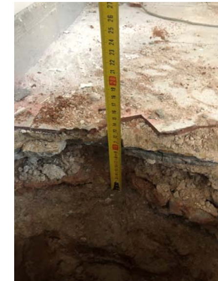
Imatges Cala A10a – Fonament en peu de façana i mur interior Nau J
