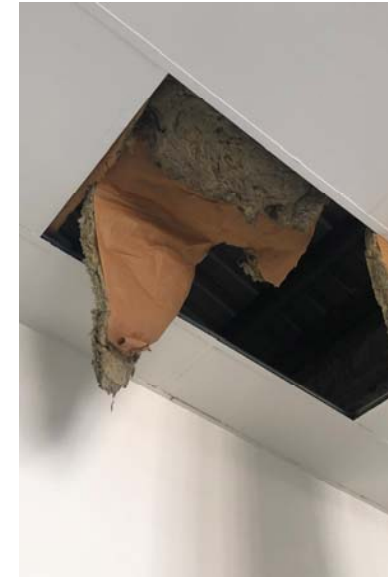
Imatges Cala C1 – Fals sostre menjador Nau C
