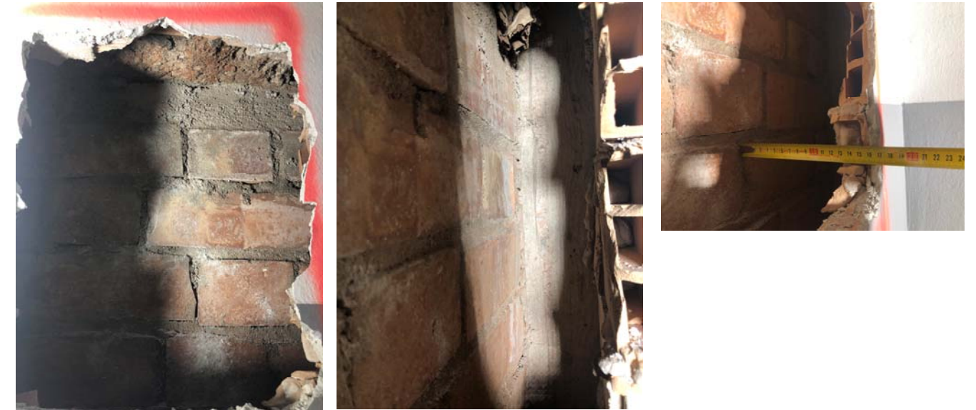
Imatges Cala B4a – Mur entre D i E – cara Nau D
