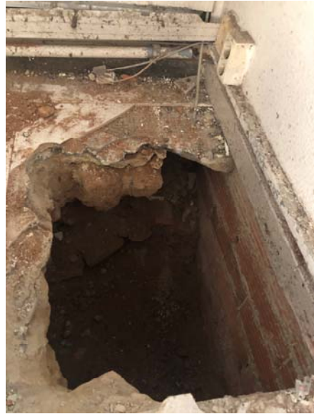
Imatges Cala A8 – Solera Nau H.2
