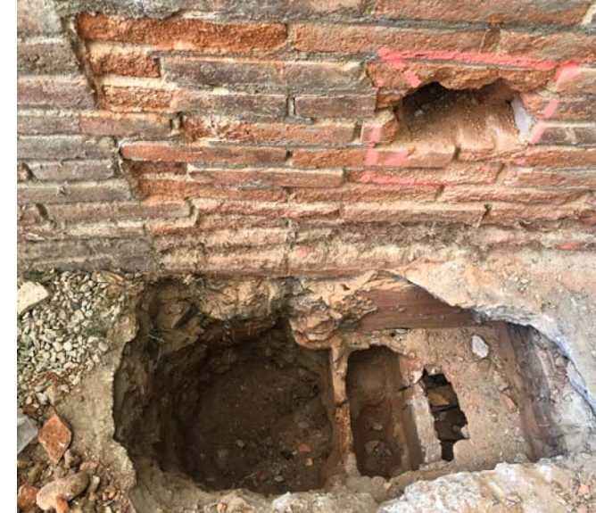
Imatges A7 – Peu de mur de contenció moll de descàrrega pati 2-3
