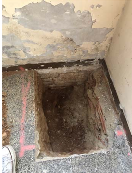
Imatges Cala A6 – Solera Nau H
