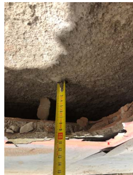
Imatges Cala B1 – Fonament en peu de mur en Soterrani Nau C i trasdossat
