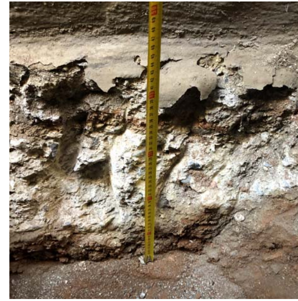
Imatges Cala 4 – Fonament mur de tancament
