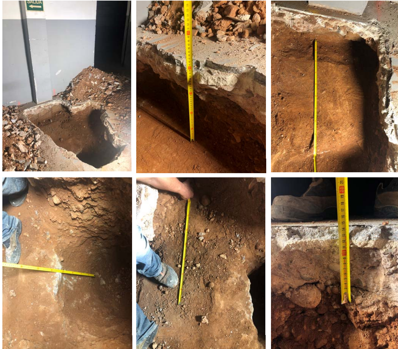
Imatges Cala B3 – Fonament en peu de pilar Nau D
