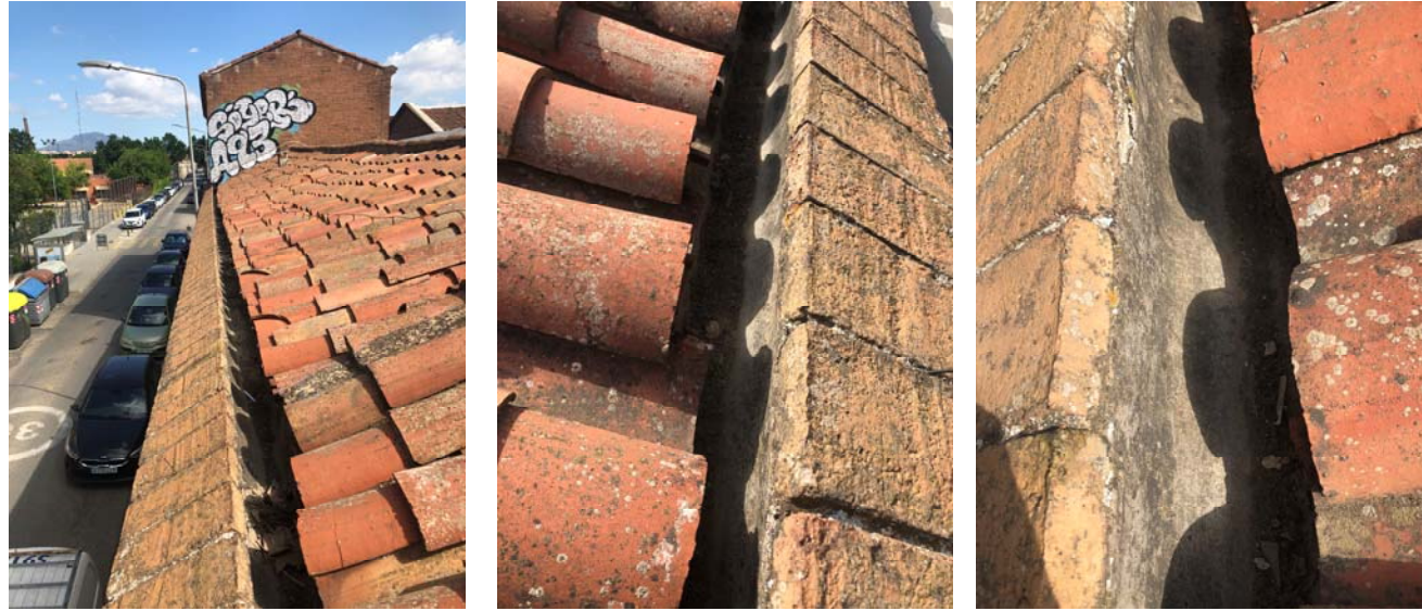
Imatges Cala C6b – Coberta Nau H.2
