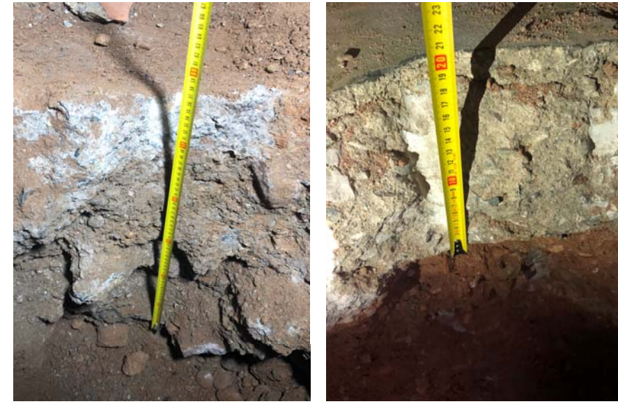
Imatges Cala B7a – Fonament en peu de pilar Nau F
