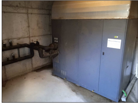
PLANTA ACTUAL AIRE-ACQUA GALLETTI LCC-105-HS
