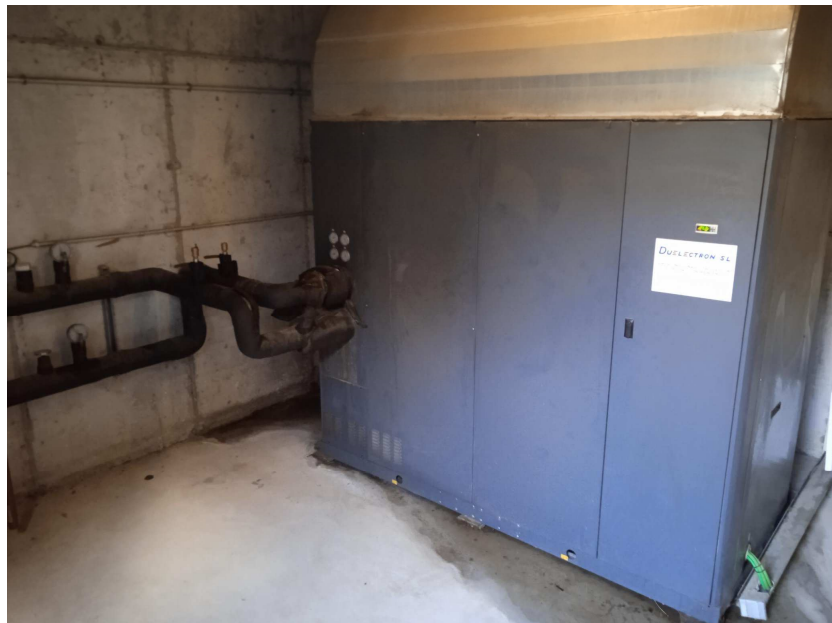
Planta refredadora actual. Model GALLETTI LCC105HS
