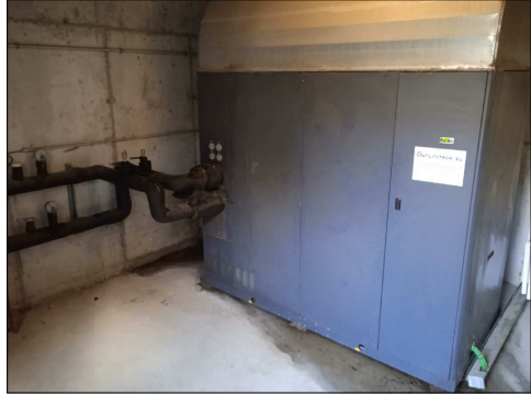
PLANTA ACTUAL AIRE-ACQUA GALLETTI LCC-105-HS
