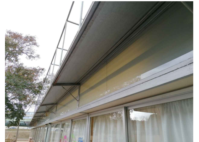
FUSTERIES A FAÇANA SUD-EST ALA SUD
