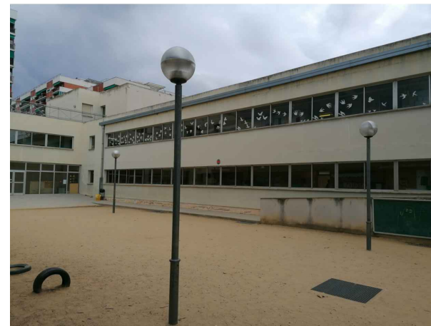
FAÇANA NORD-OEST ALA SUD
