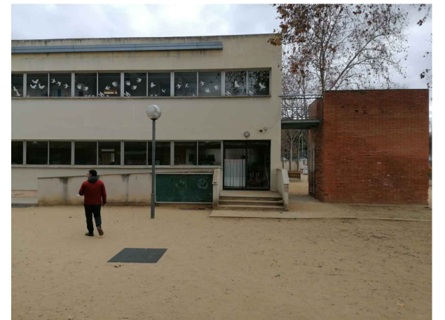
FAÇANA NORD-OEST ALA SUD
