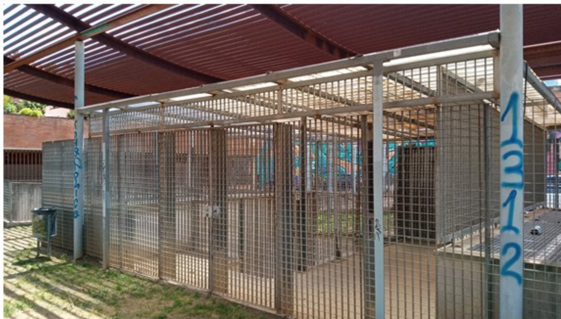
ESCALES ACCÉS APARCAMENT SOTERRANI EXISTENT COSTAT C. PARE SALLARÈS
