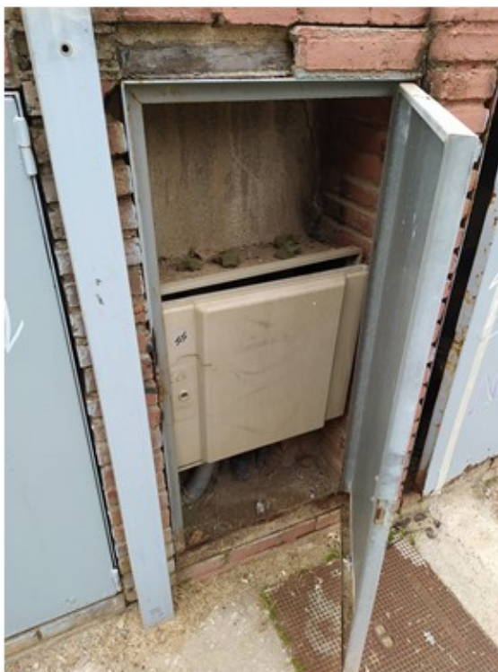
ARMARI INSTAL·LACIÓ ESCOMESA ELECTRICITAT C.G.P. EXISTENT
