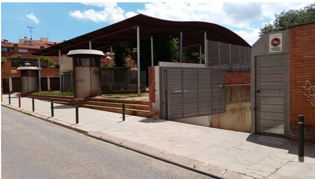
VISTA PÈRGOLA I ACCESOS A L'APARCAMENT SOTERRANI DES DEL CARRER ESCOLA PIA INTERVAL NÚM. 69-69B
