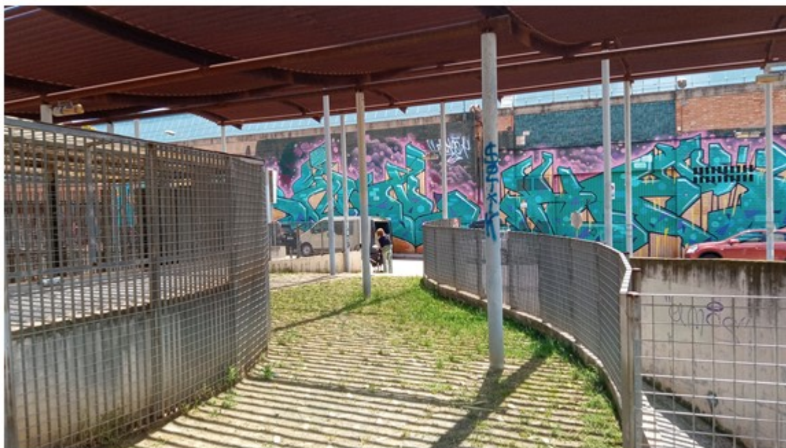
ACCÉS CENTRAL, ESCALA I RAMPA DES DEL C. PARE SALLARÈS
