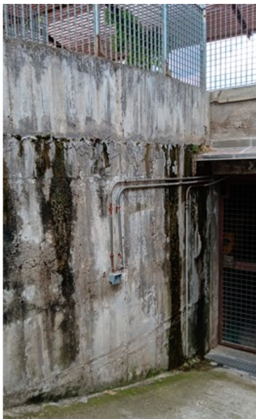
DETALL HUMITATS EXISTENTS MUR F.A. RAMPA VEHICLES
