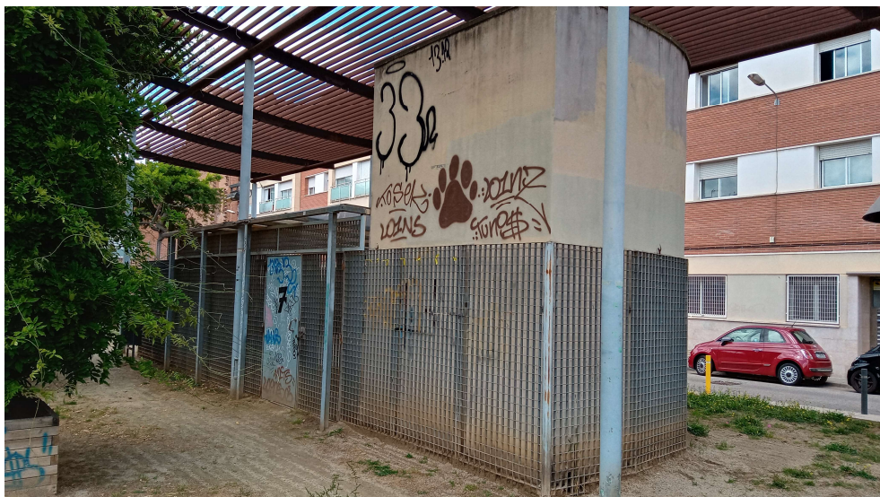
Nucli d'escaleres existent accés aparcament soterrani c. Escola Pia (imatge existent a reformar)
