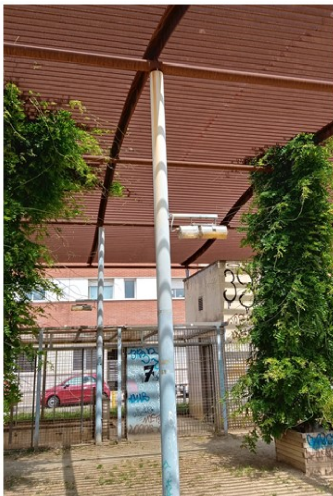
ACCÉS APARCAMENT SOTERRANI EXISTENT COSTAT C. ESCOLA PIA
