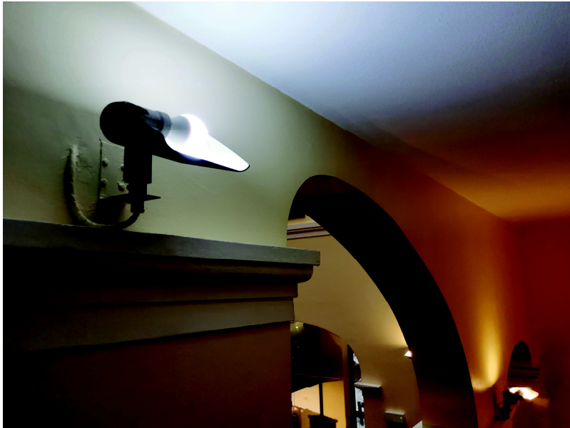
Il·luminació escala i vestíbul
