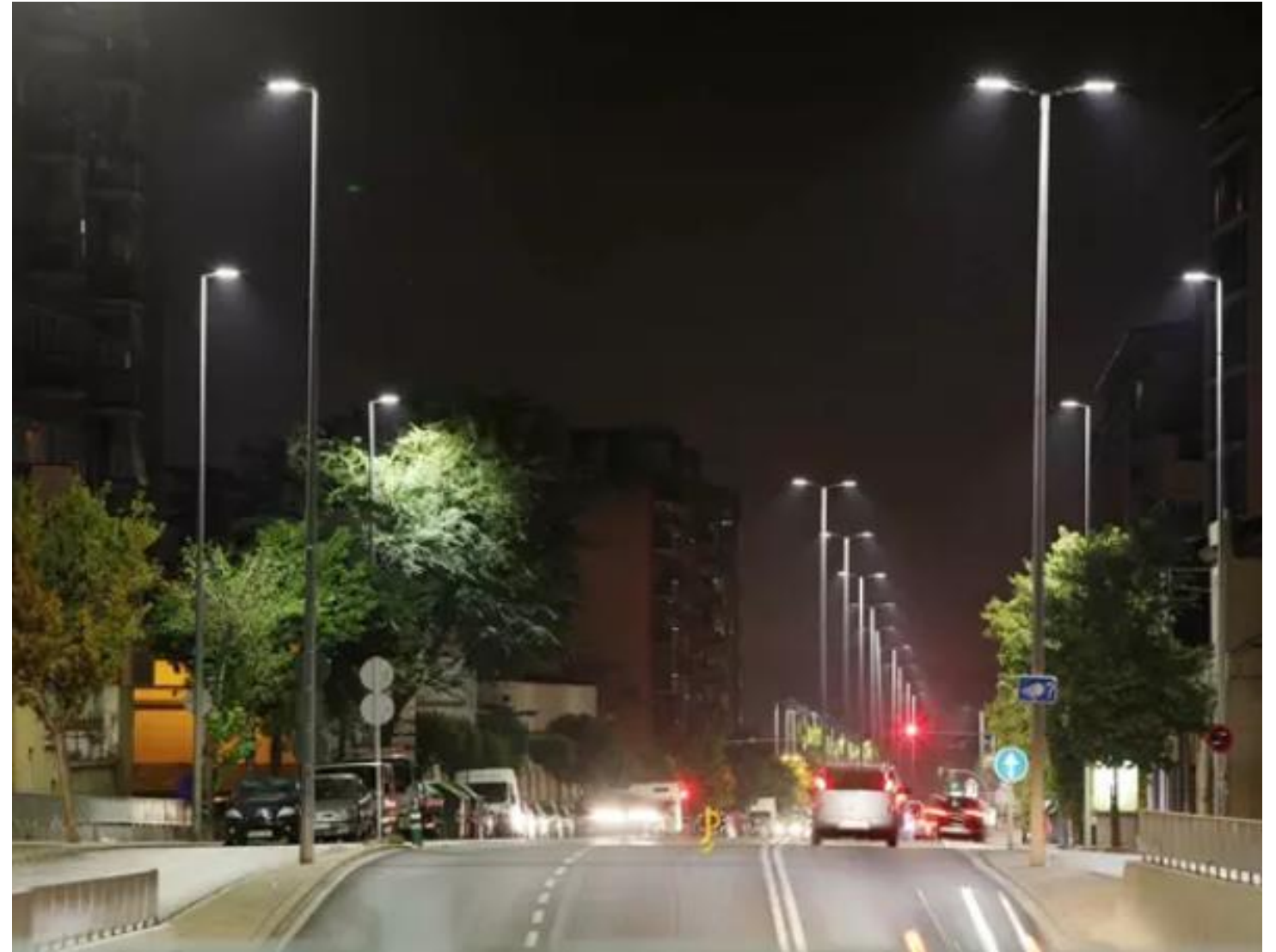
PROJECTE DE SUBSTITUCIÓ DE FANALS A SABADELL
