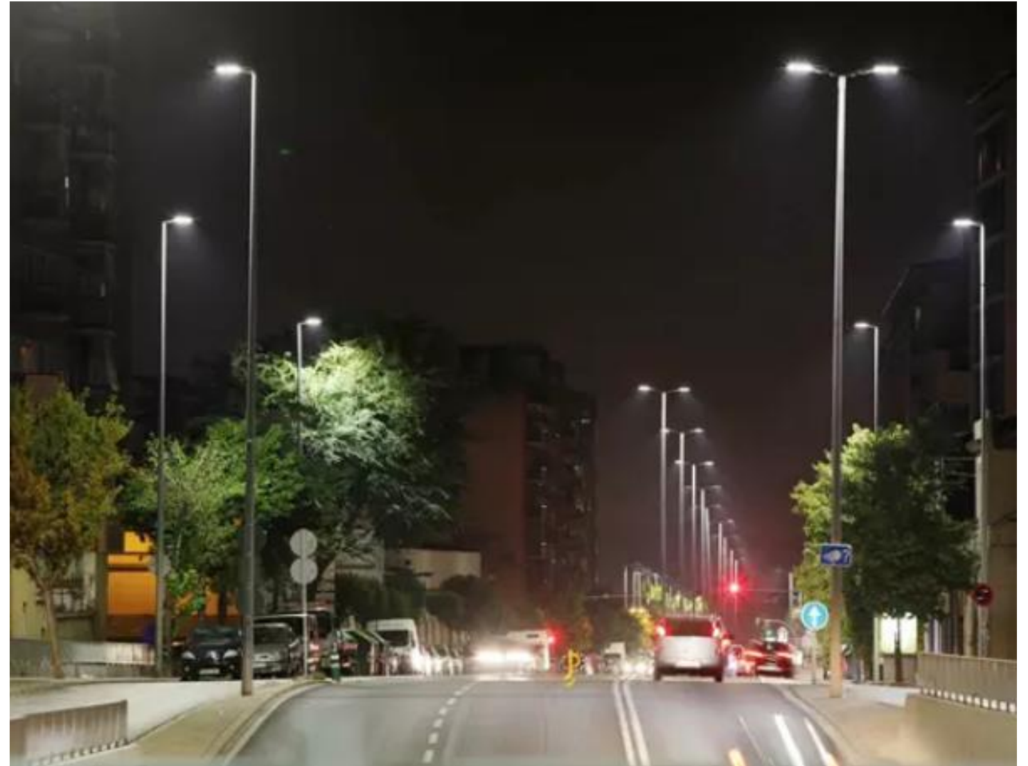
PROJECTE DE SUBSTITUCIÓ DE FANALS A SABADELL
