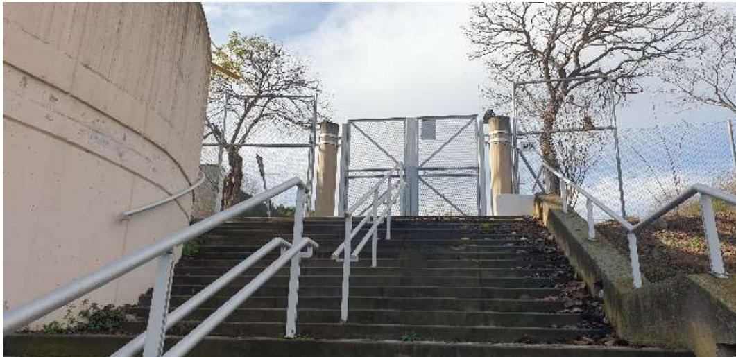
Vista des de l'interior. Recorregut ascendent (P2)
