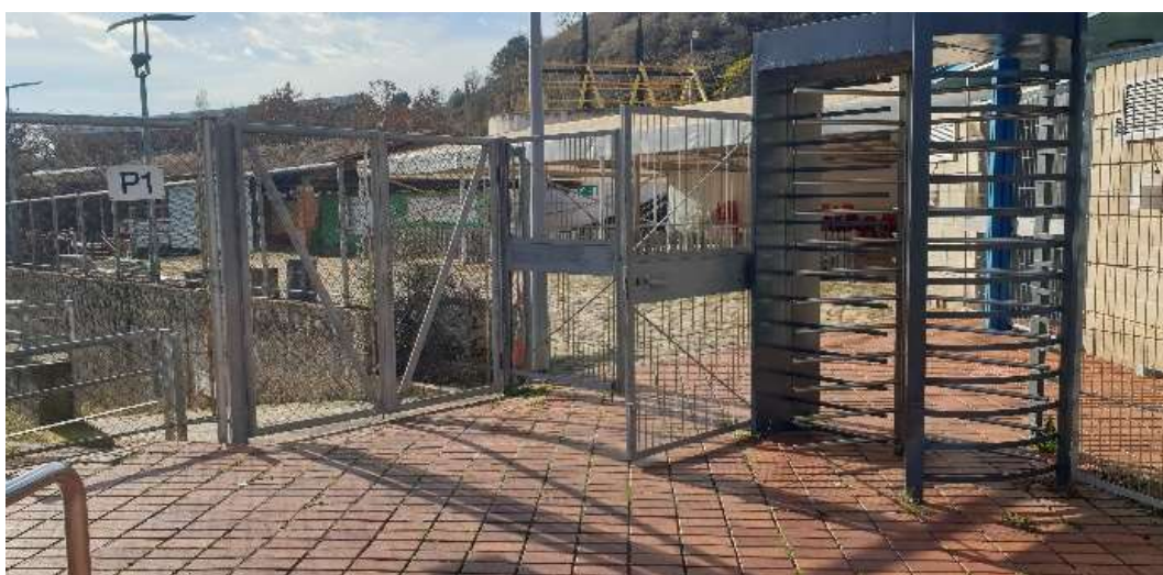
Vista des de l'exterior (P1)
