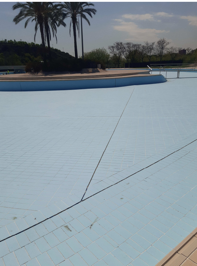
Juntes de dilatació en paviment. Peces de paviment tallades
