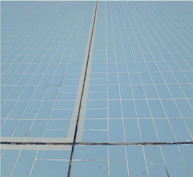
Detall de l'encintat de la junta previ al segellat
