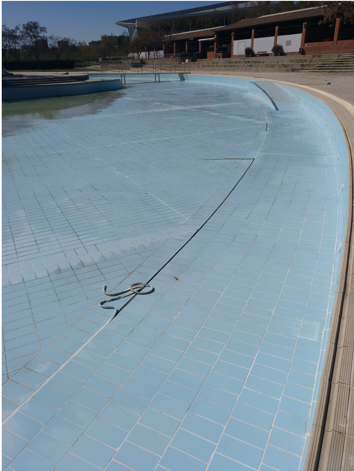
Cordó de segellat de junta aixecat per l'ús
