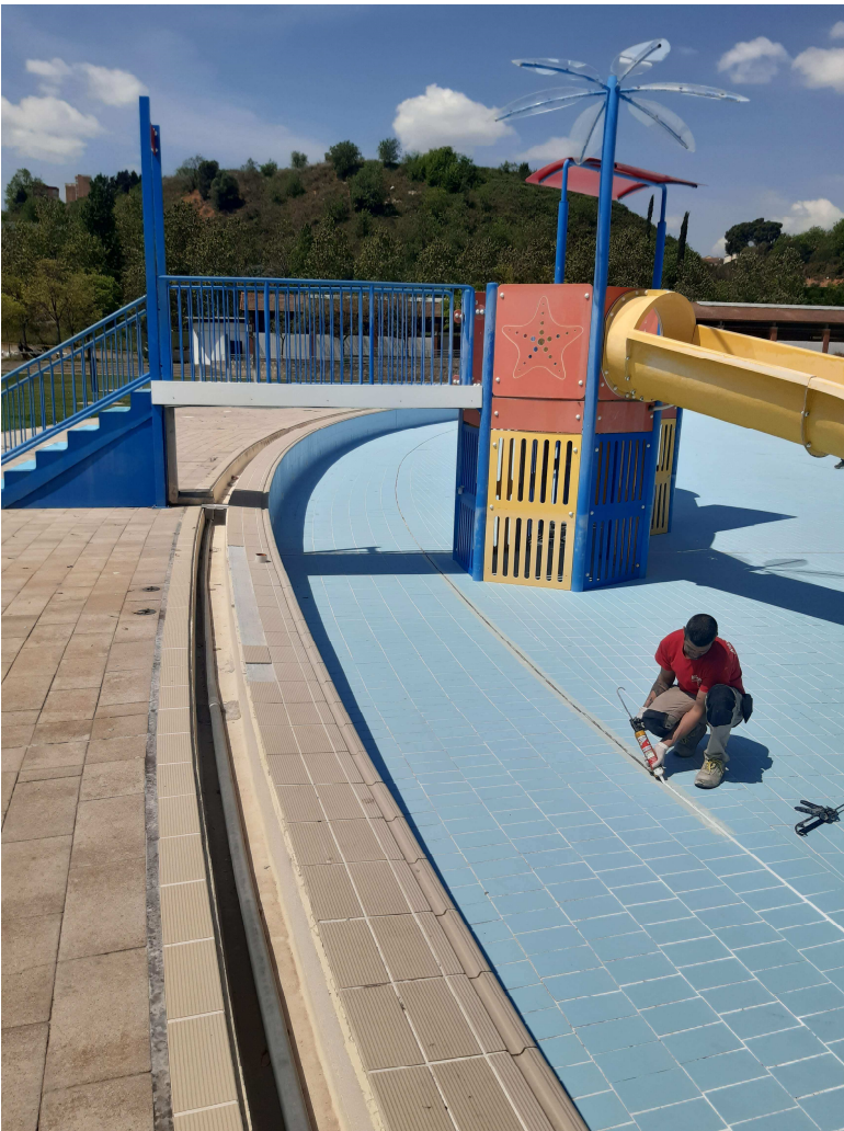
Procés de segellat de junta
