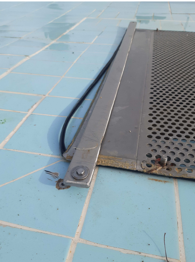
Detall ancoratge a paviment
