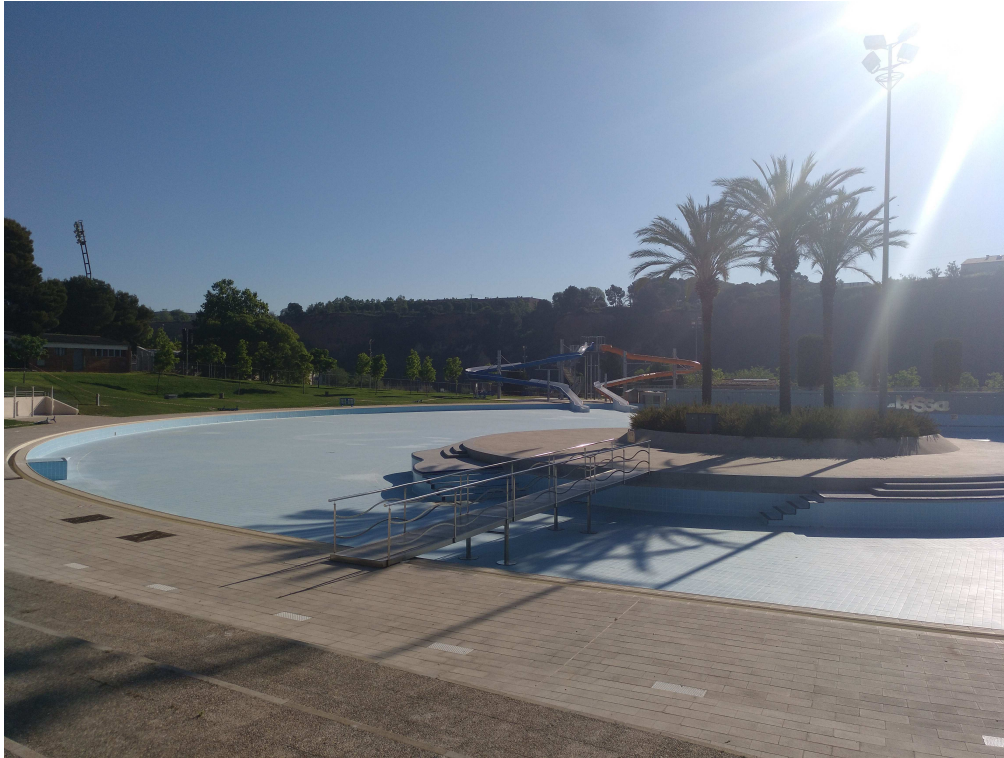
Vista general piscina buida
