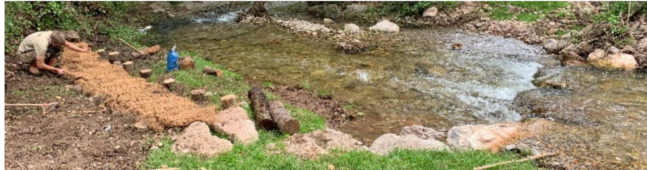
Figura 9. Exemple d'estructura J-vane executada al riu Ripoll.
