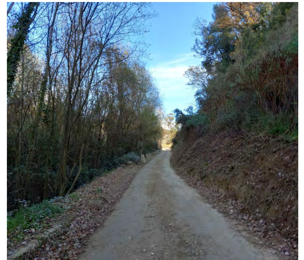
Fotografia del tram d'actuació
