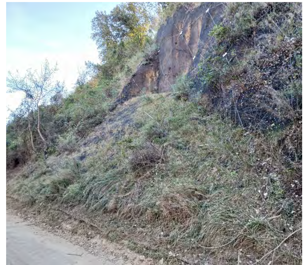
Fotografia del tram d'actuació
