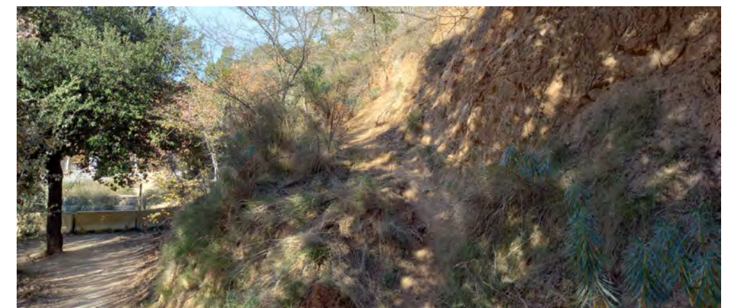
Fotografies del tram d'actuació
