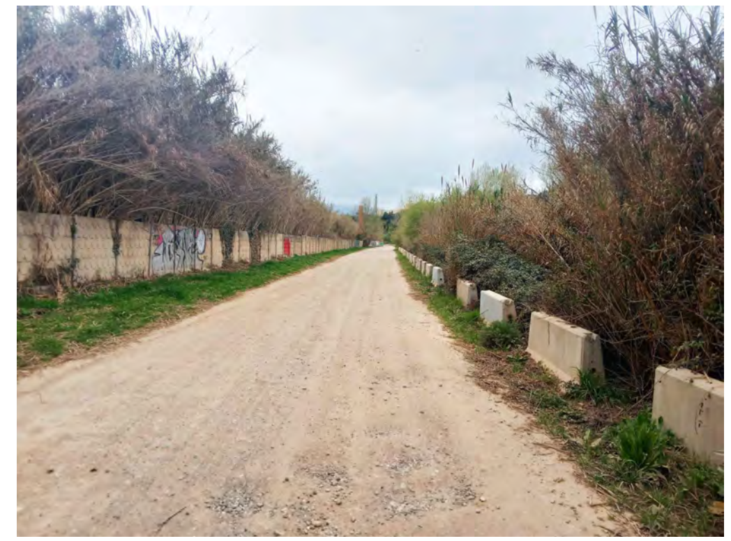
Fotografies del tram d'actuació
