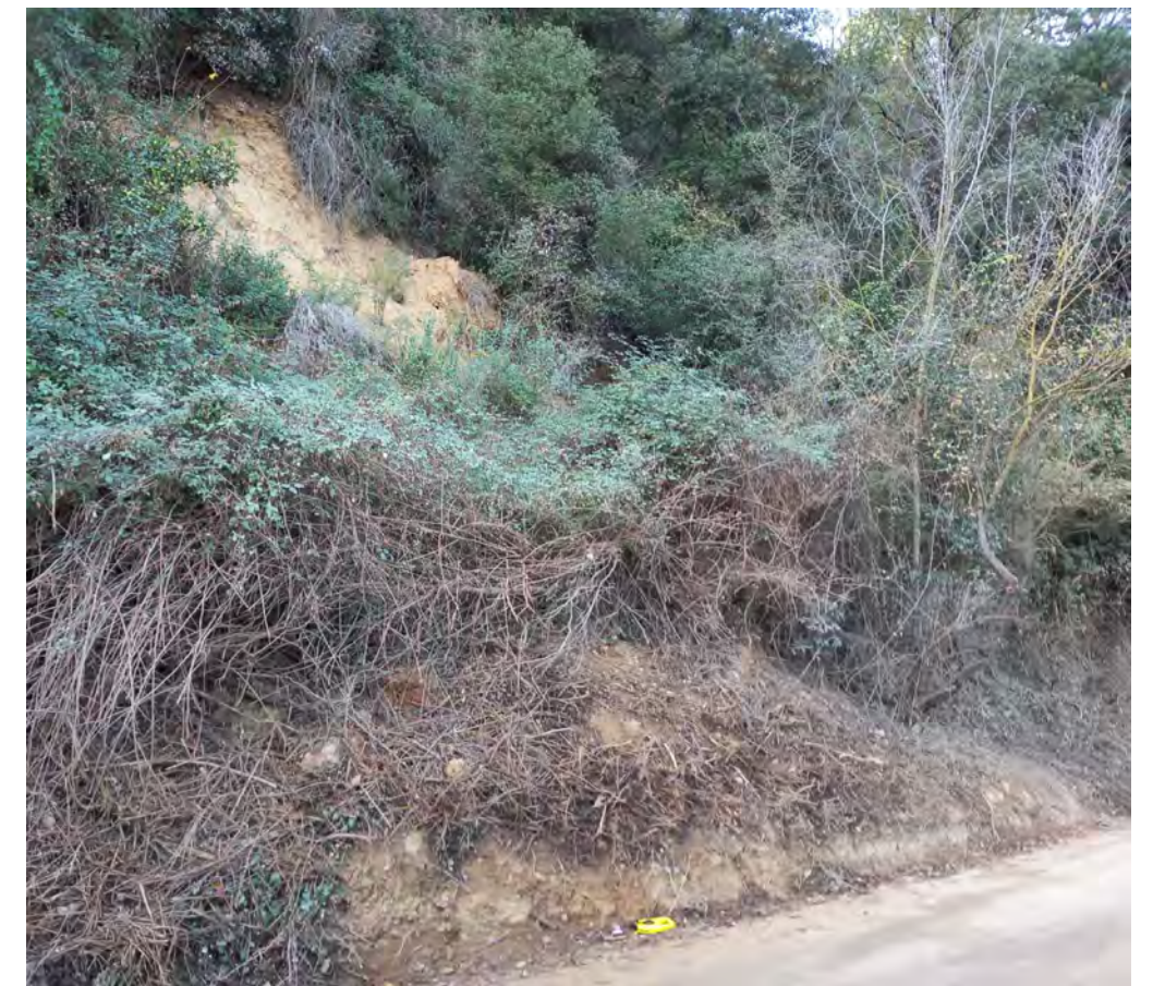
Fotografia del tram d'actuació
