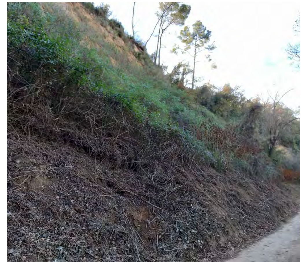
Fotografia del tram d'actuació
