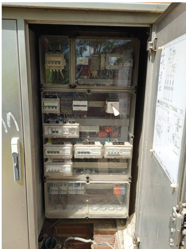
El quadre d'enllumenat on es penjarà el circuit, el 335, és l'indicat. A sota, fotografia de l'interior del quadre
