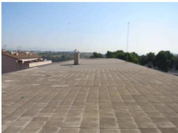
Coberta amb rajola filtrant filtrant
