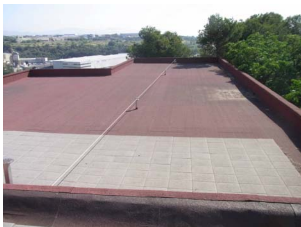
Coberta amb tela autoprotegida i rajola
