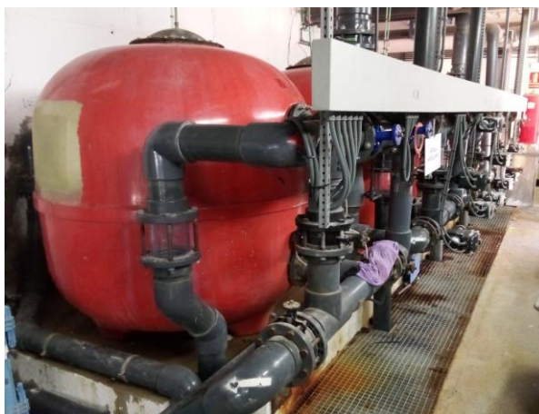
Estat actual dels filtres
